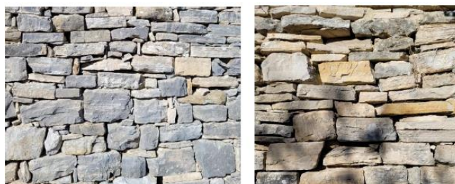
Exemples de murs en pierres sèches locales
